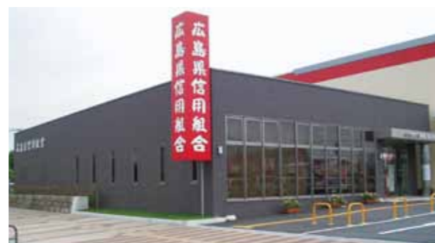
福山支店 移設(H22年11月)
